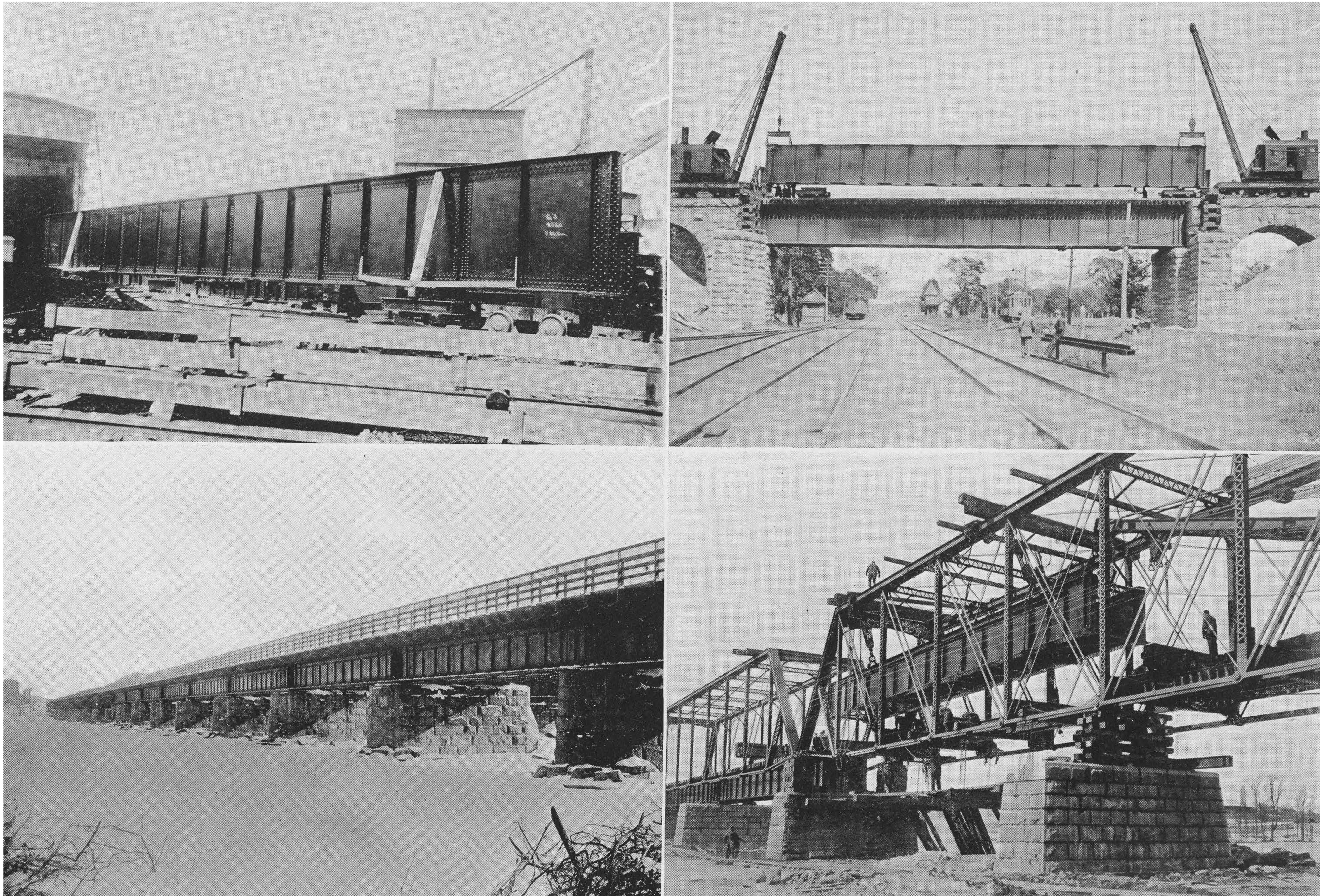
C. P. R. over G. T. R. at Rockfield, Que.
